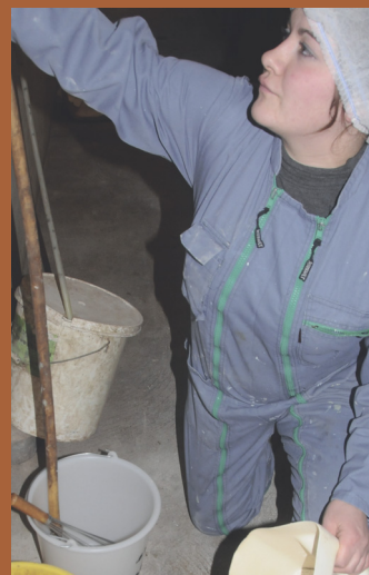
Mettre 2,5 litres d'eau propre pour 1 kg de Delta-Attivia.
